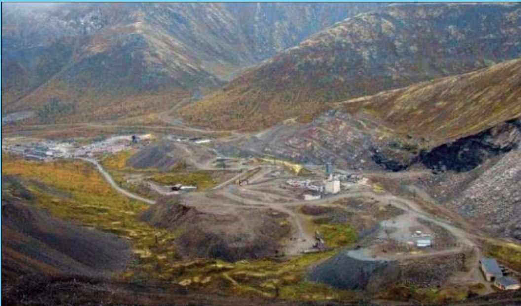
Şəkil 6. Qarabağda yollarda və yol tikintisində ekoloji riskli, uçqun təhlükəli yerlərin mənzərəsi
